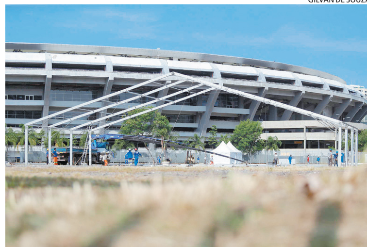
Construção de hospital de campanha no Maracanã, Zona Norte do Rio
