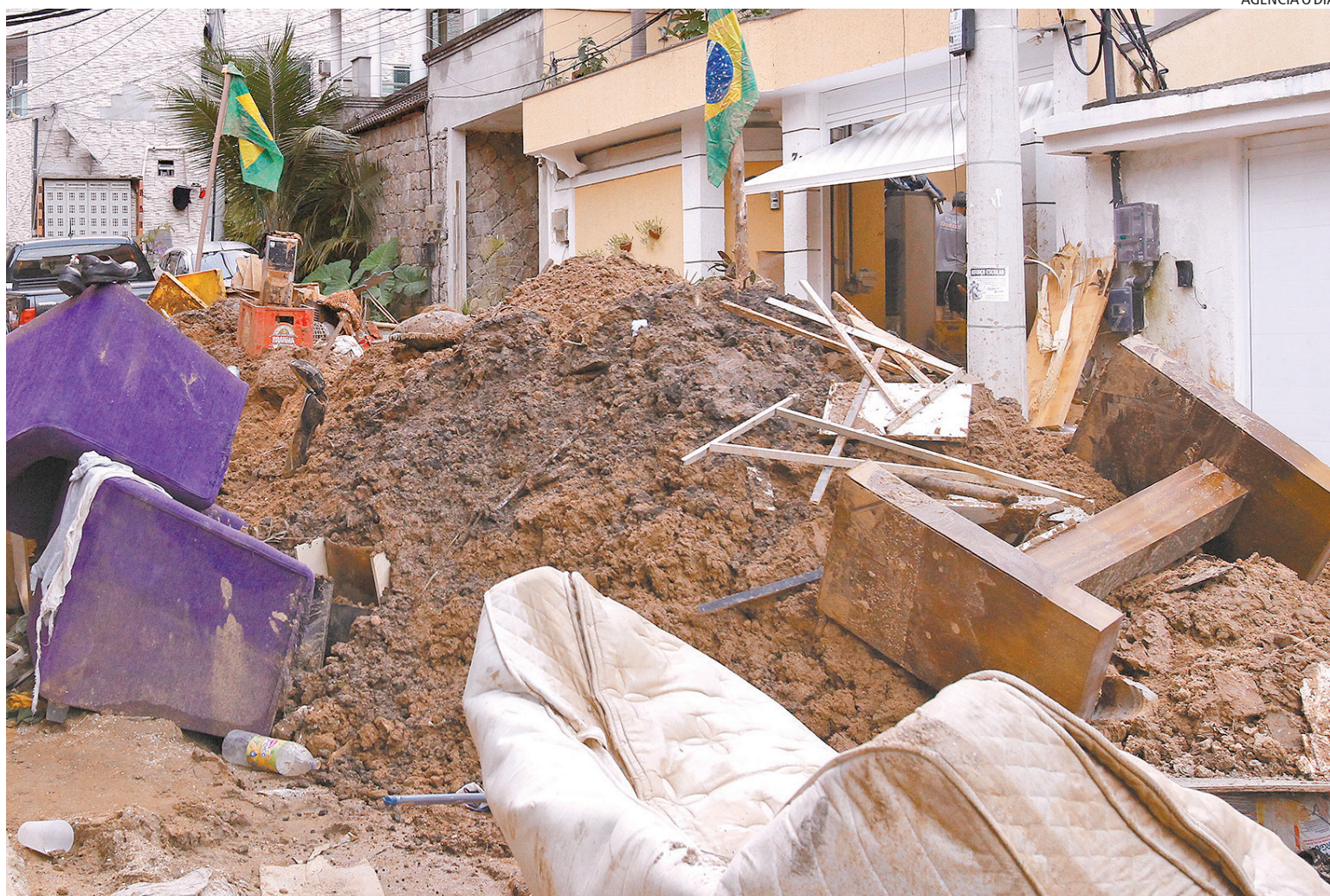
Desabamento de prédios na Muzema, no Itanhangá, em 2019: dominada pela milícia, área tem construções irregulares
