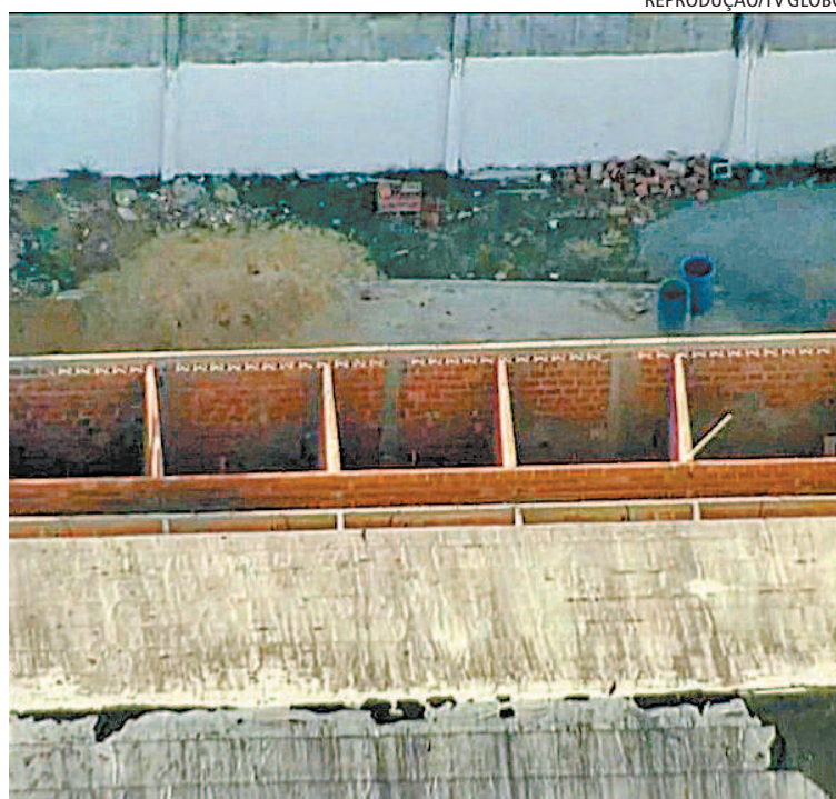
Construção na Cadeia Pública Jorge Santana foi brechada pelo órgão
