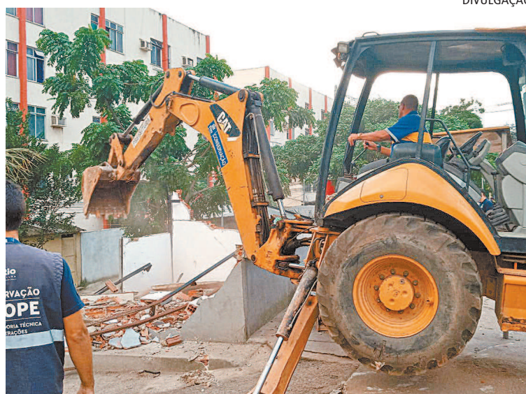
Agentes da prefeitura derrubam construções irregulares na CDD
