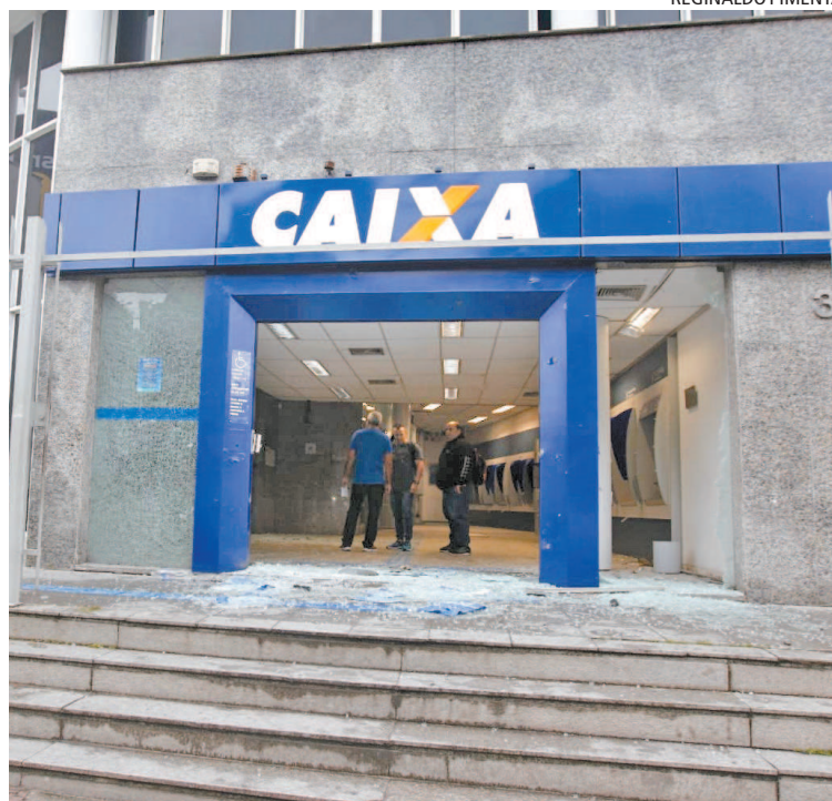
Vidros da agência bancária ficaram destruídos após a explosão
