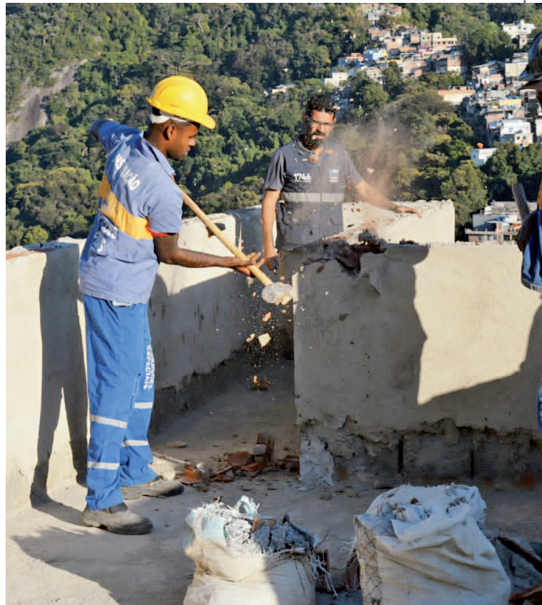
Com três andares e vista pra praia, casarão do vagabundo foi demolido
