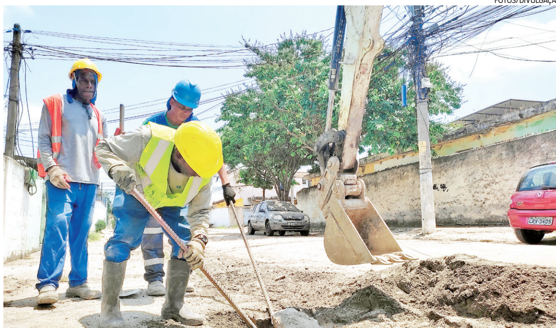
Diversos bairros recebem obras para substituição de nove km de rede de água na Zona Oeste
