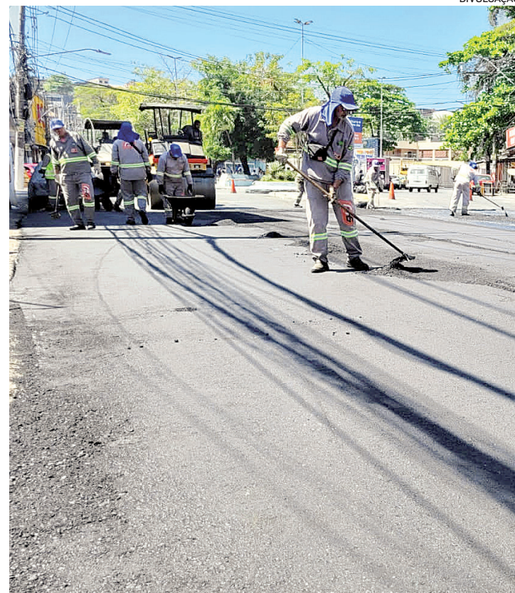
Pavimentação é realizada em parceria com o governo do estado
