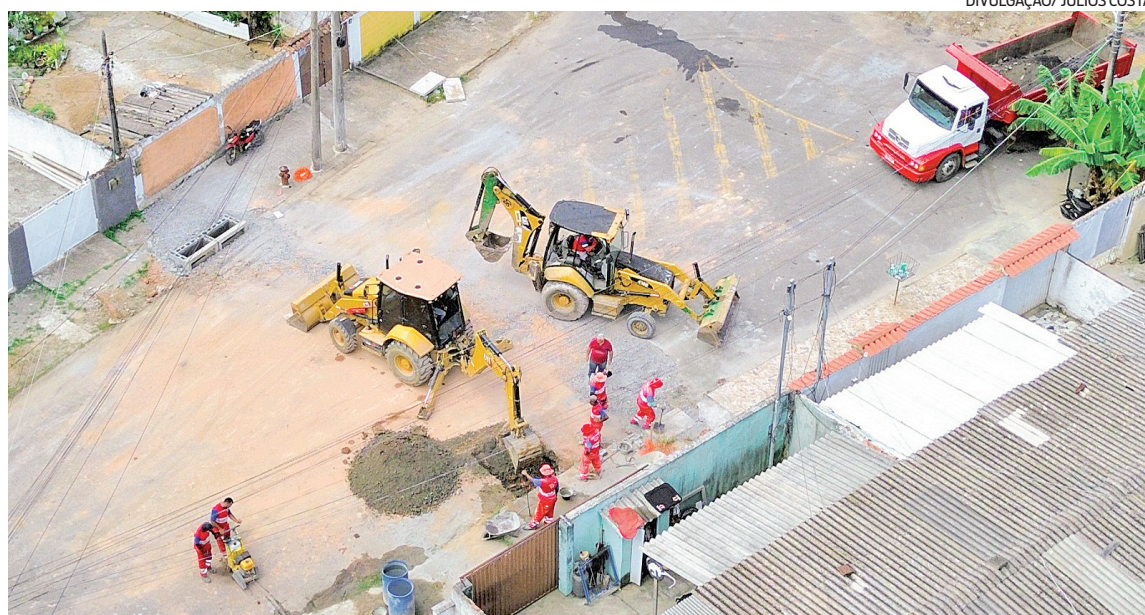
Operação ‘tapa-buraco’ tem como objetivo recapar o asfalto da RJ-106, além de avenidas da cidade
