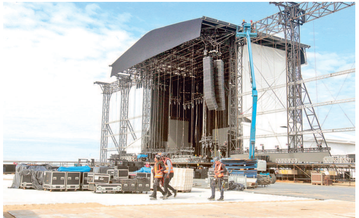
Preparativos do palco e toda a estrutura para o show de Lady Gaga, na Praia de Copacabana, Zona Sul
