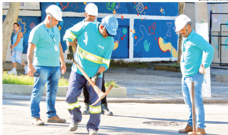
Trabalhadores realizaram reparo do bueiro na Rua Cirne Maia
