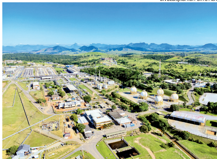
Tepor está sendo construído junto ao Terminal de Cabiúnas
