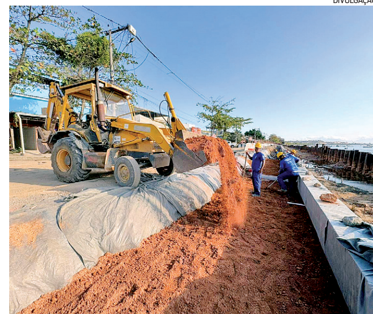
Obras na Pedrinhas vão permitir maior atividade turística na área
